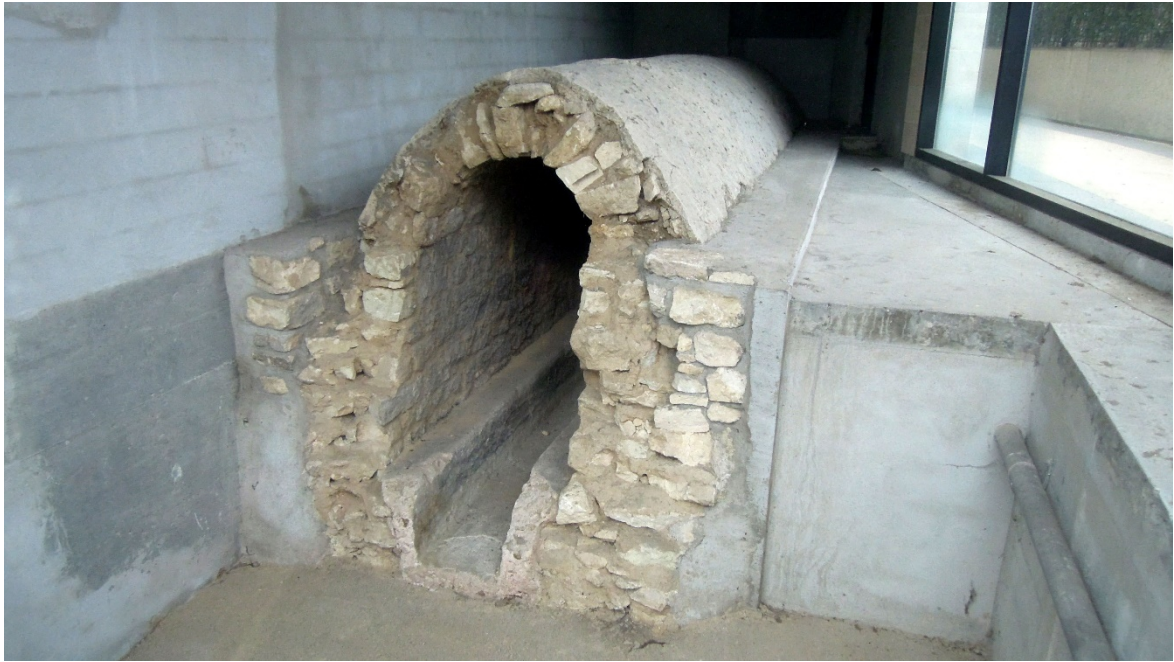
Tronçon d'un aqueduc
