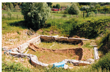
Bassin de captage des sources
